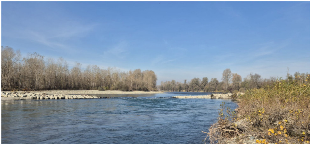
Figura 6.6 – I due rami della Dora Baltea, ramo principale e ramo secondario, sono delimitati da opere di difesa (blocchi e prismi) in calcestruzzo (fonte: ripresa privata novembre 2025)
